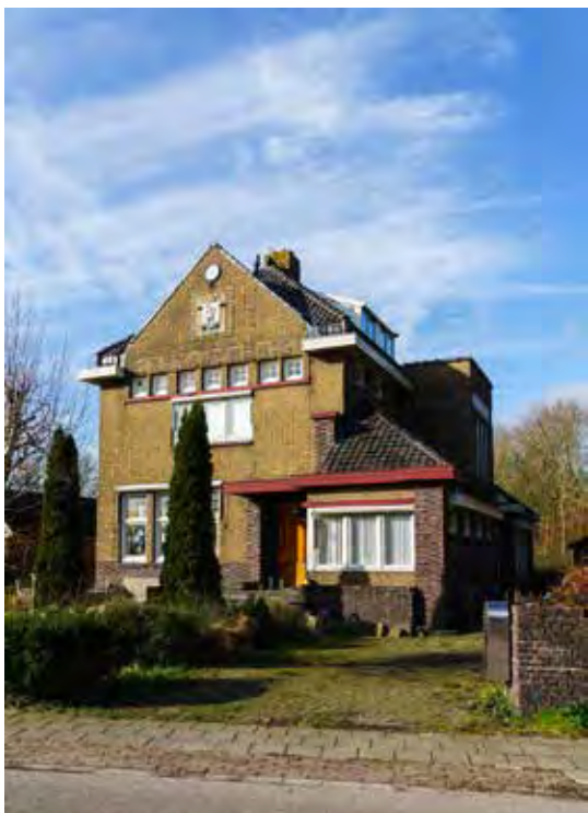
Afb. 2. Jan Benninga, Gemeentehuis, Hoofdstraat 101, Nieuwolda, Karakteristiek Pand, 1929. Foto Geert Boiten.
