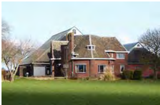
Afb. 3a. Jan Benninga, voorkant voorhuis villaboerderij, Korendijk 13, 't Zandt, rijksmonument, 1929. Foto Hans Rümke.
