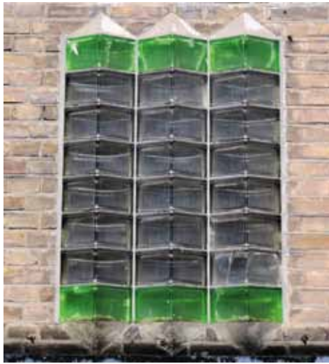
Afb. 4. Bouwstenen Nieuwstraat 58 en 69, Jetze Janzen, 1924. Foto Eddy Engelsman.
